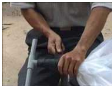
Photo 54. On place un nouveau tube en forme de « T » à l'autre ouverture du futur réservoir : un bout sera connecté au digesteur, l'autre à l'appareil alimenté en biogaz
