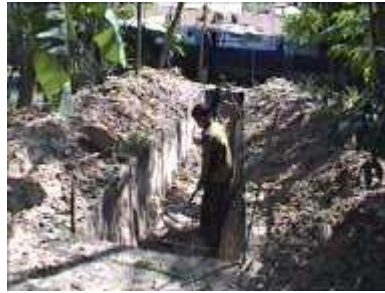
Photo 5. Réalisation d'une tranchée dans le sol
