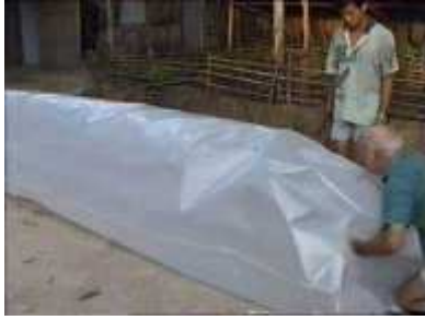
Photo 29. Le digesteur est rempli d'air
