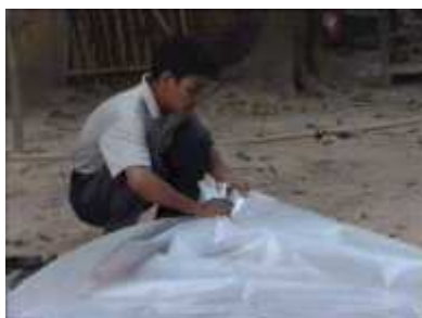
Photo 51. On bouche un des deux bouts du cylindre de plastique qui servira de réservoir (il peut être d'une longueur de 3m)
