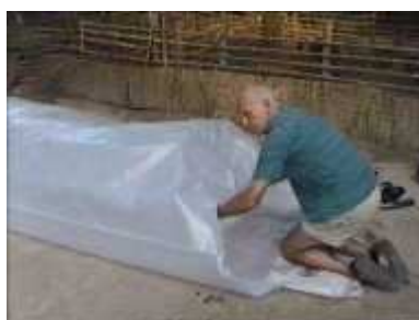
Photo 28. On pompe l'air pour remplir le digesteur
