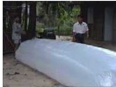
Photo 38. Le digesteur est maintenant rempli d'air
