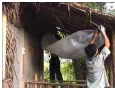
Photo 58. On suspend le réservoir en dessous du toit
