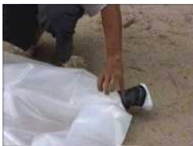
Photo 51. On bouche un des deux bouts du cylindre de plastique qui servira de réservoir (il peut être d'une longueur de 3m)
