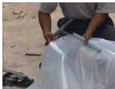
Photo 54. On place un nouveau tube en forme de « T » à l'autre ouverture du futur réservoir : un bout sera connecté au digesteur, l'autre à l'appareil alimenté en biogaz
