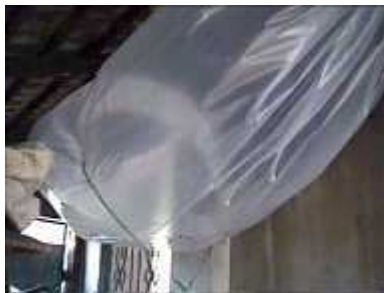
Photo 78. Augmenter la pression dans le réservoir (pb 7)
