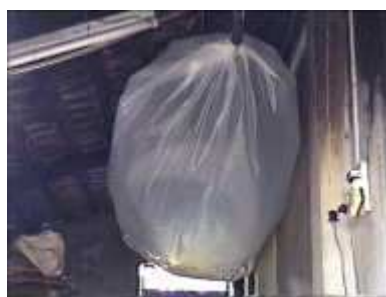
Photo 59. Un réservoir biogaz rempli !!
