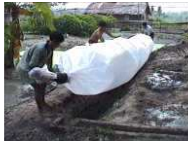
Photo 40. On place le digesteur dans la tranchée
