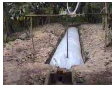
Photo 67. L'installation est terminée
