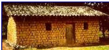
Une fois sèches, elles sont assemblées au moyen d'un mortier de terre humide. Une armature de bois est parfois utilisée en renforcement.
